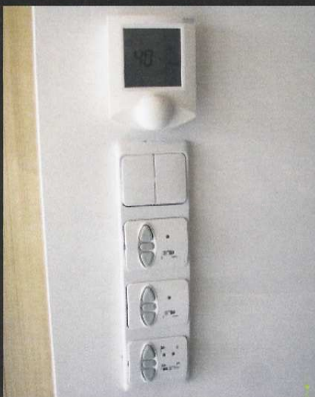
Riadenie slnečných clon je závislé nielen od intenzity slnečného žiarenia a rýchlosti vetra, ale aj od teploty vzduchu v zimnej záhrade. Najmä v zime sa clony sťahujú, až keď je v zimnej záhrade dostatok tepla.
